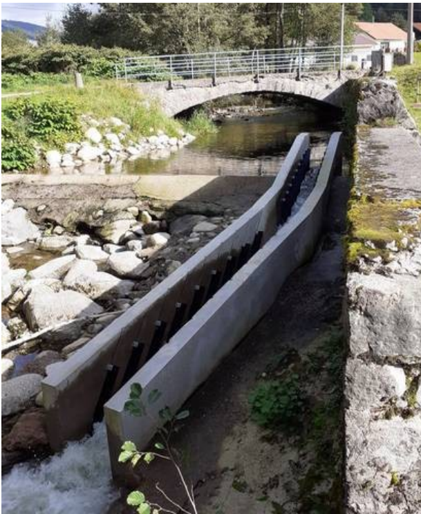
Barrage des Grands Meix (barrage Grenelle)
